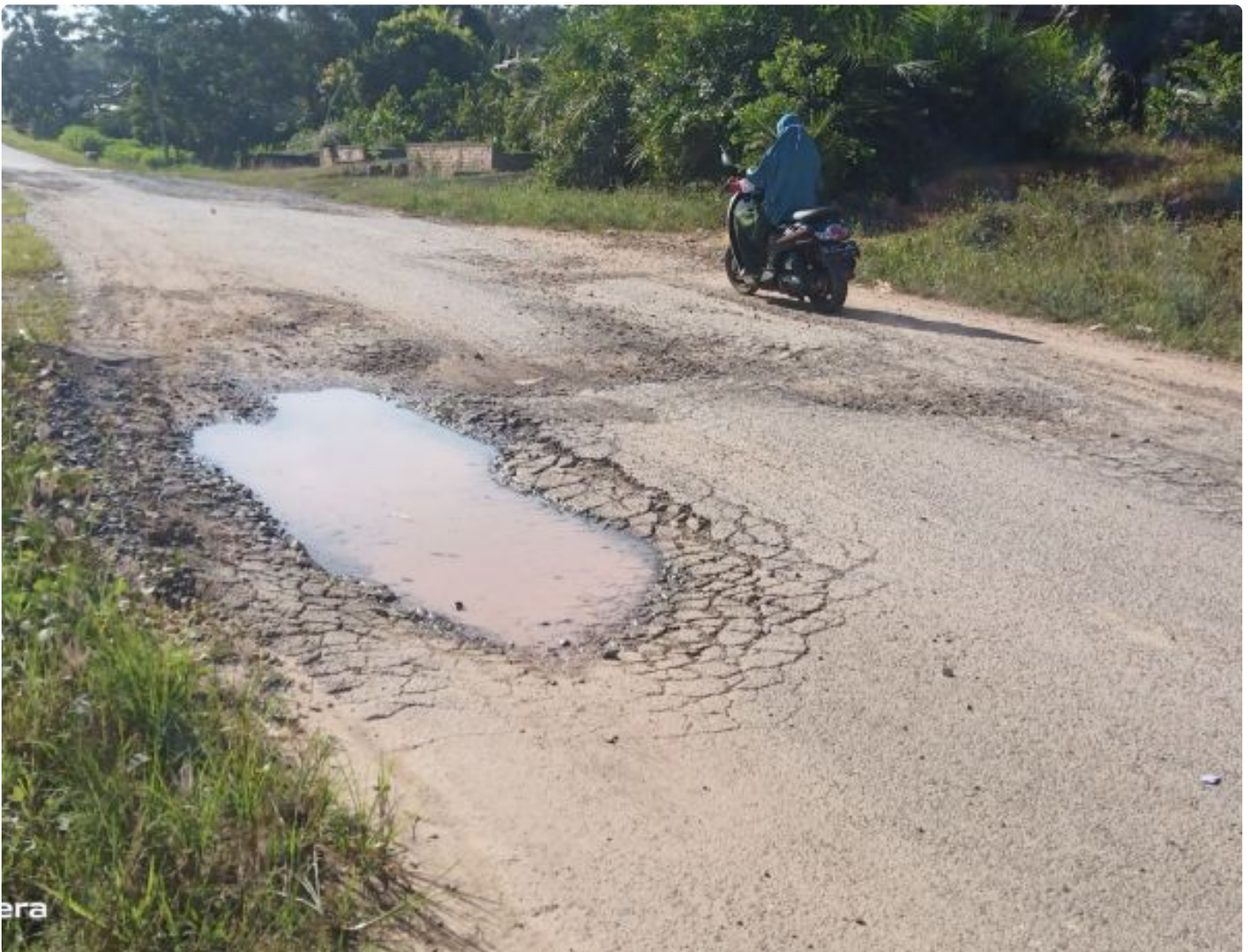
Ruas Jalan Kabupaten Arah Bengkok
