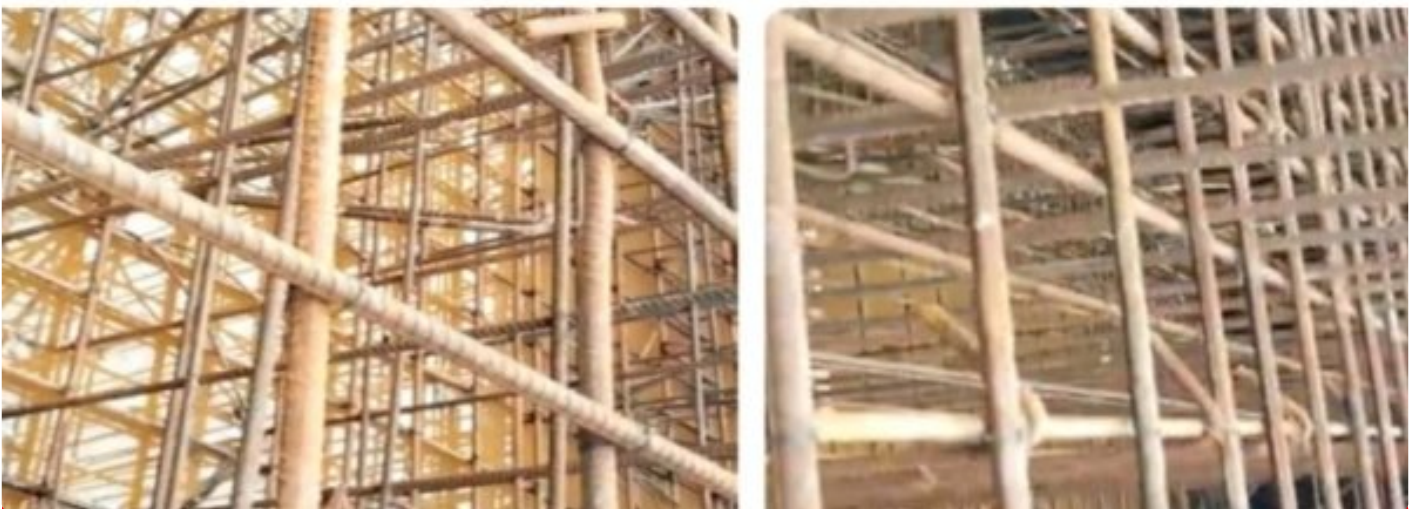
Proyek Jembatan Gantung
