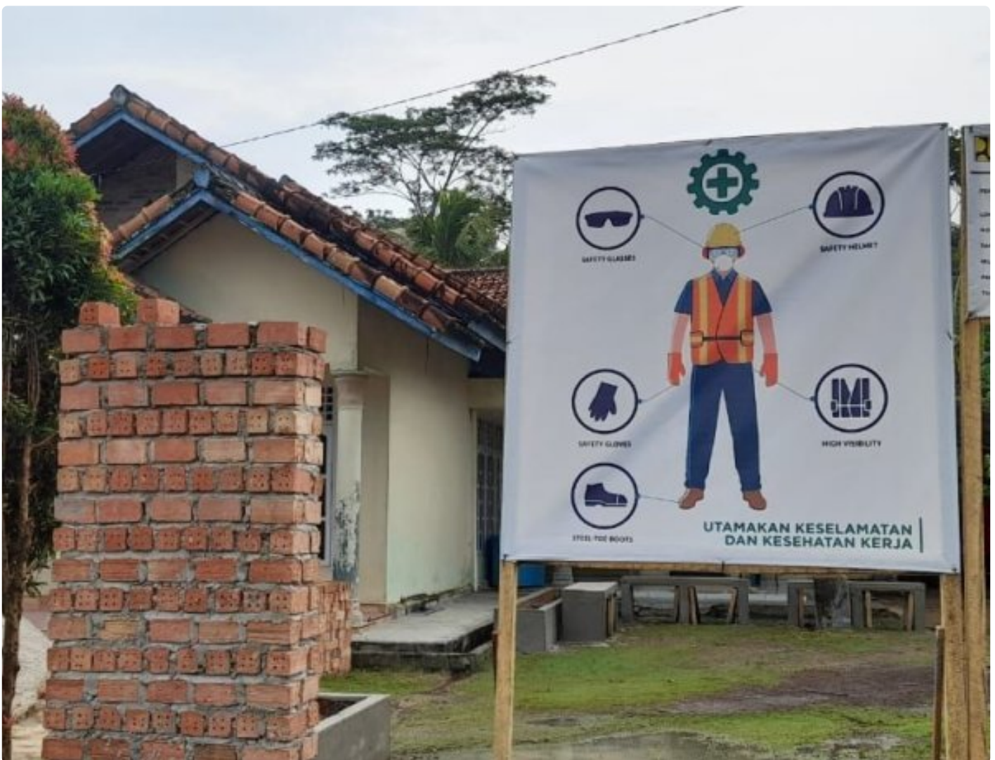
Proyek Infrastruktur Hunian Hijau di Mesuji
