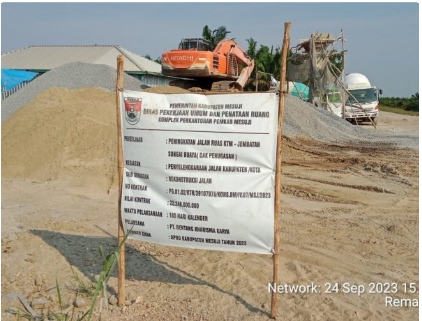
Pekerjaan rigit beton pada ruas penangkis Sungai Buaya Mesuji
