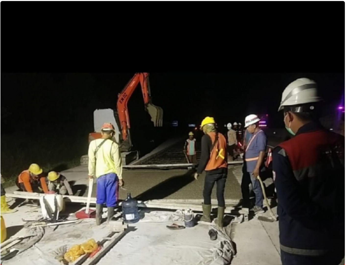
PT HKI Perbaiki Tol Terbanggi Kayu Agung
