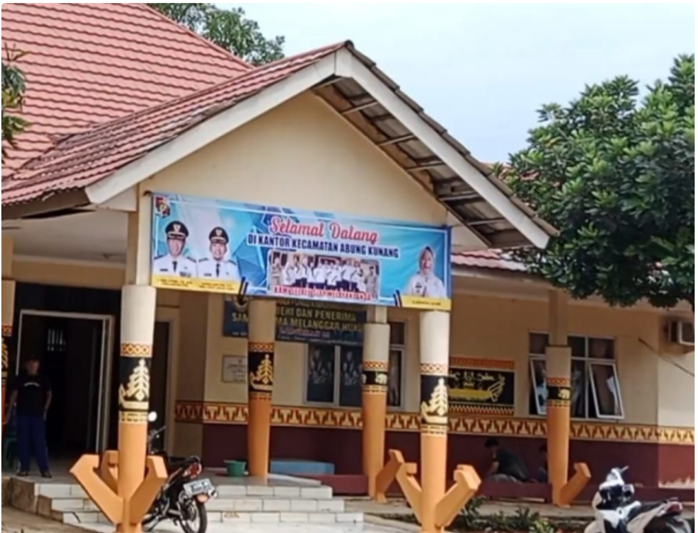
Kantor Camat Abung Kunang Kabupaten Lampung Utara
